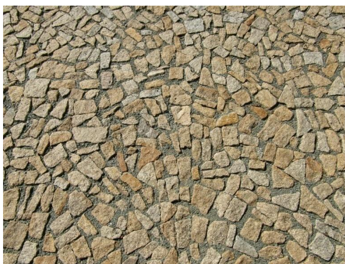
Příklad - štípané nepravidelné žluté žulové dlažby - "odseky"
